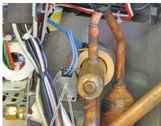
Figure 117 - Dépose de la bobine de la vanne à 4 voies
