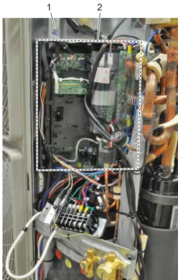
Figure 94 - Dépose du boîtier électrique (1~ ERLQ011-016CV3 uniquement)
