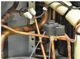
Figure 114 - Dépose du moteur de la vanne de détente Y3E
