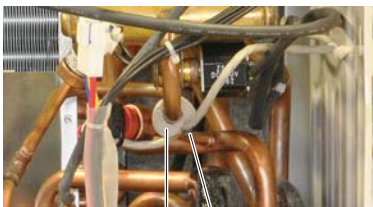
Figure 76 - Dépose de la vanne à 4 voies
