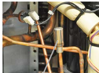
Figure 114 - Dépose du moteur de la vanne de détente Y3E
